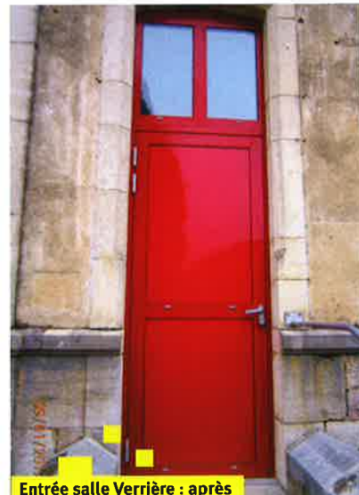
Entrée salle Verrière : après
