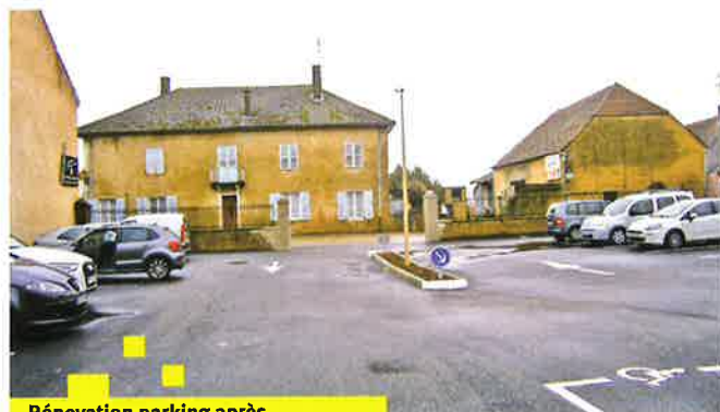
Rénovation parking après
