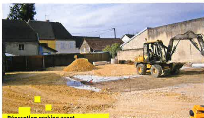
Rénovation parking avant
