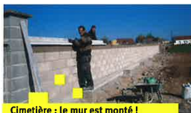
Cimetièrre : le mur est monté !
